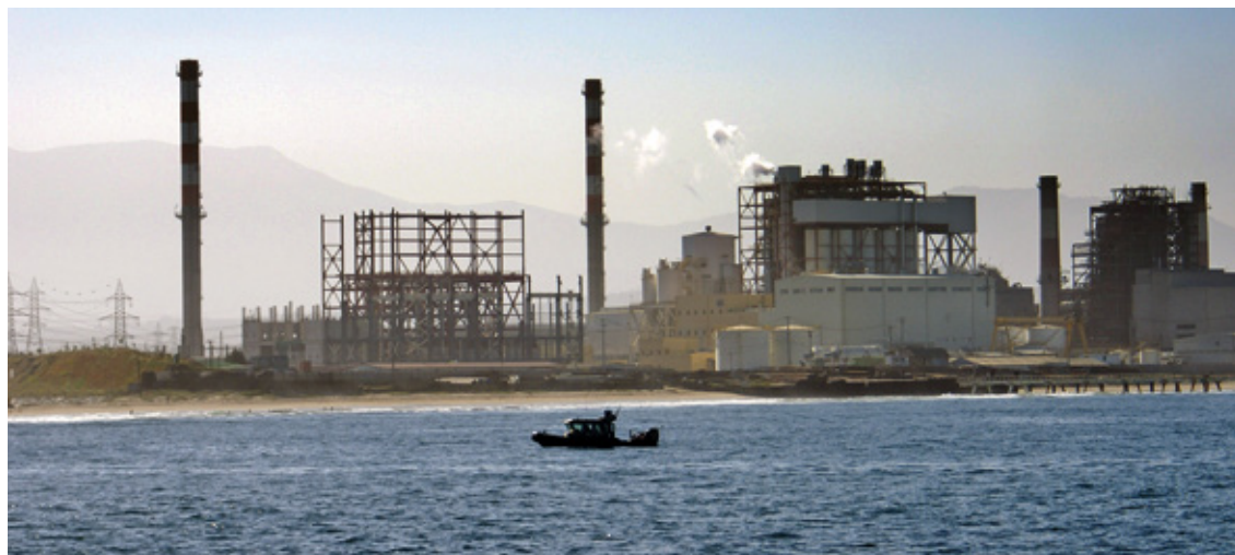
Central termoeléctrica, Archivo MMA.
